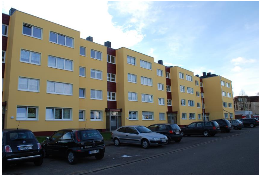
Karl-Arnold-Str. 116 - 122 - nach Modernisierung
