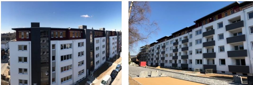
Baufortschritt der Pestalozzistr. 1 - 9
